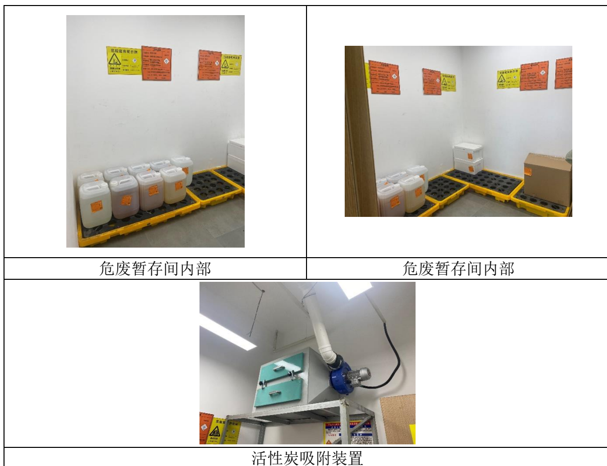
图 4-4 依托现有工程 4 层危险废物暂存间照片
